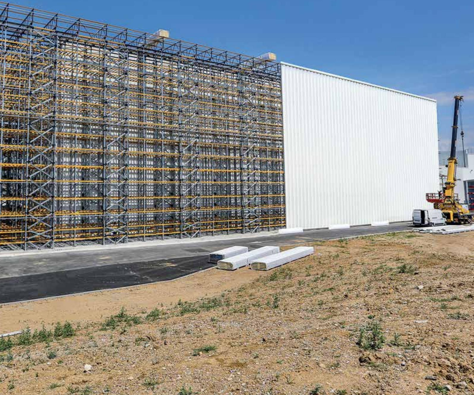
Selbsttragende Lager verkürzen die Bauzeit und führen zu erheblichen Kosteneinsparungen. Ideal für Gebäude, die prinzipiell zur Einlagerung einer Höchstmenge an Waren gedacht sind. Die Lagerbedienung erfolgt mittels herkömmlichen Staplersystemen oder automatisierten Regalbediengeräten.
