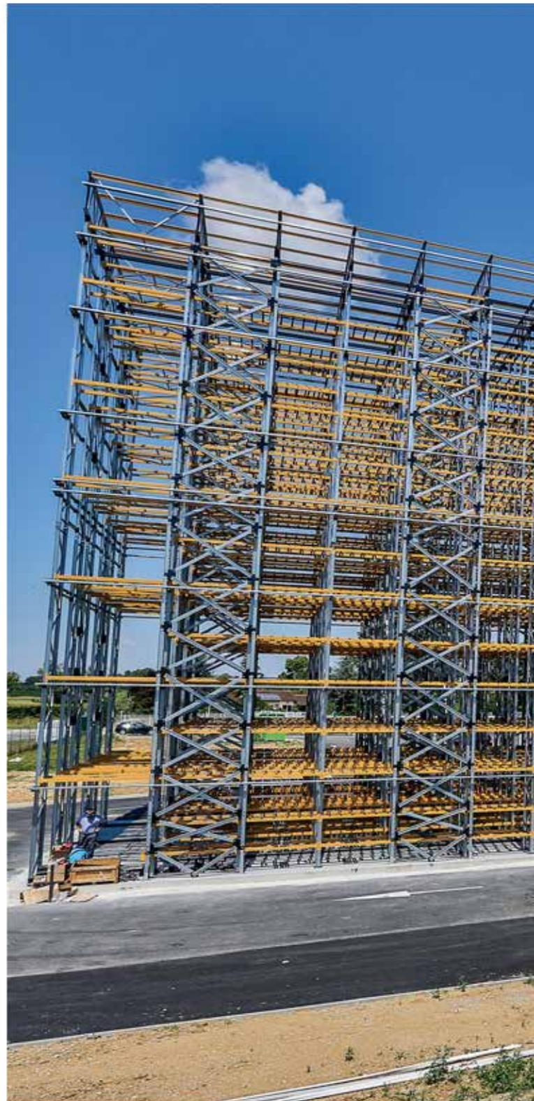
Mit selbsttragenden Lagerbauten lassen sich massive zeitliche Einsparungen für den Bau einer Lagerhalle sowie hohe Kosteneinsparungen erzielen.
